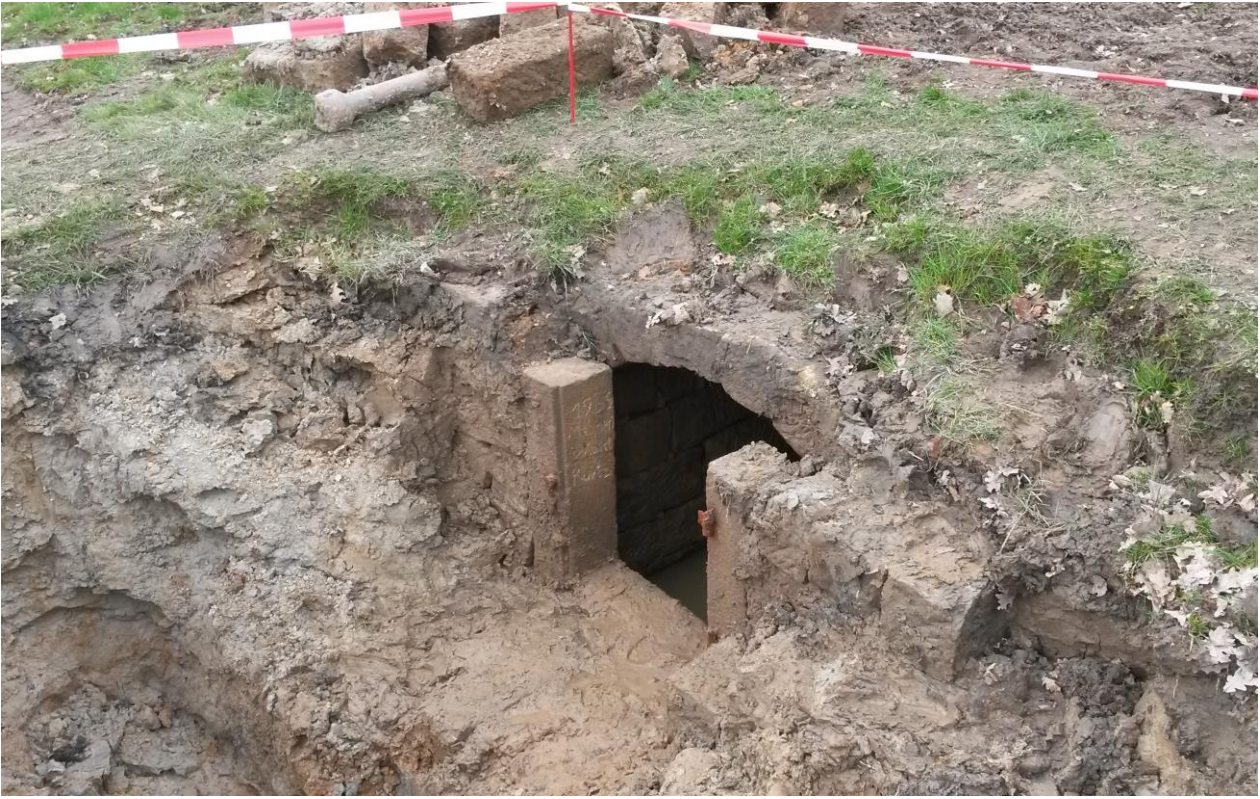
Bild 5: Zugangsbereich des aufgefundenen Sandsteingewölbes
