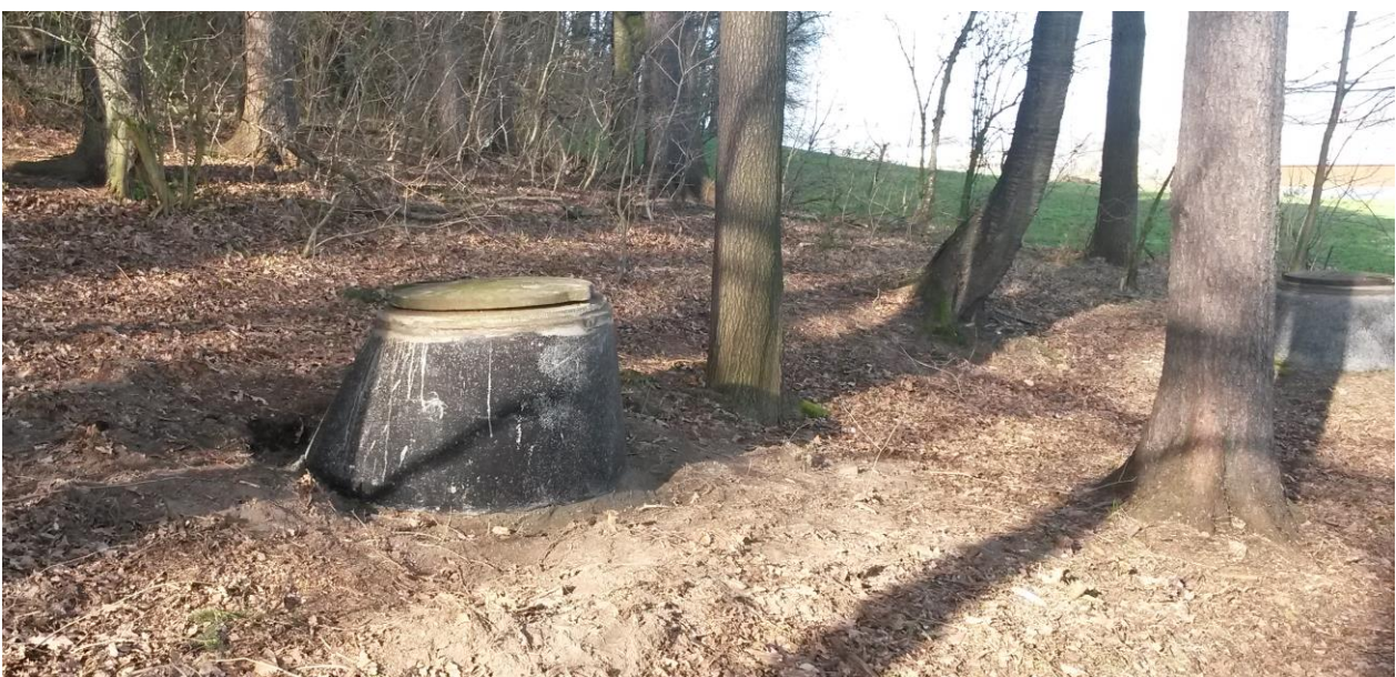
Bild 4: Zustand der beiden östlichen Fassungsschächte nach der Sanierung
