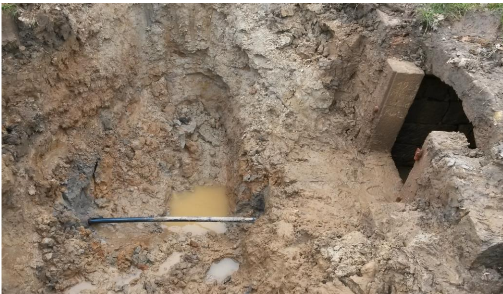
Bild 9: Erneuerte Ablaufleitung aus PE-HD
