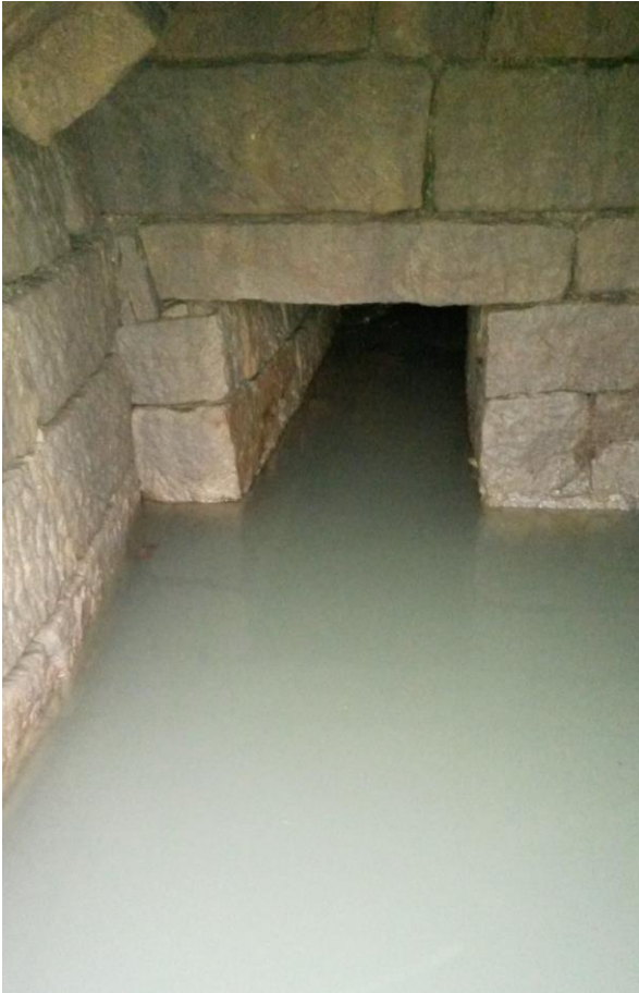
Bild 7: Blick in das Innere des Gewölbes Deutlich erkennbar im Hintergrund ist der tiefe horizontale Schacht zur Sammlung von Sickerwasser
