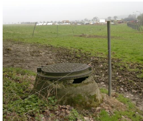
Bilder 2 und 3: Zustand von östlichem und westlichem Fassungsschacht vor der Sanierung
